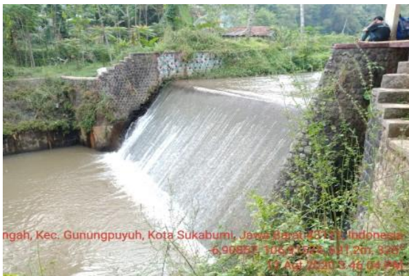
Gambar 8: Bendungan sungai desa Karang Tengah
