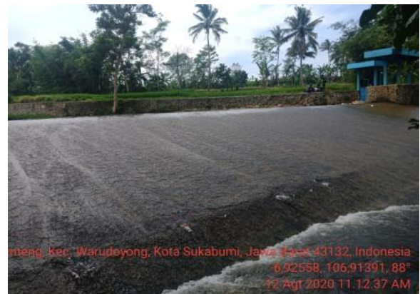
Gambar 4: Bendungan sungai desa Dayeuhluhur
