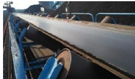
Gambar 8. Bagian Sisi Bell Conveyor Yang Terkikis
