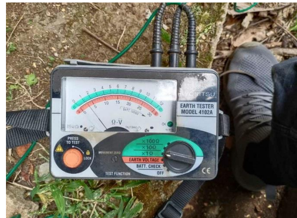
Gambar 6. Pengukuran resistansi pbumian instalasi listrik setelah perbaikan
