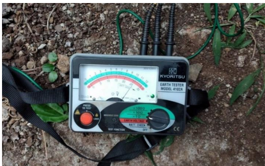
Gambar 5. Pengukuran resistansi pbumian instalasi listrik sebelum perbaikan
