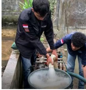
Gambar 13 : Pengujian pompa lumpur.
