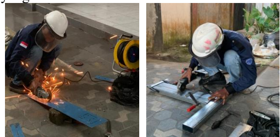
Gambar 3 : Pemotongan Plat Besi Bracket & Besi Hollow
